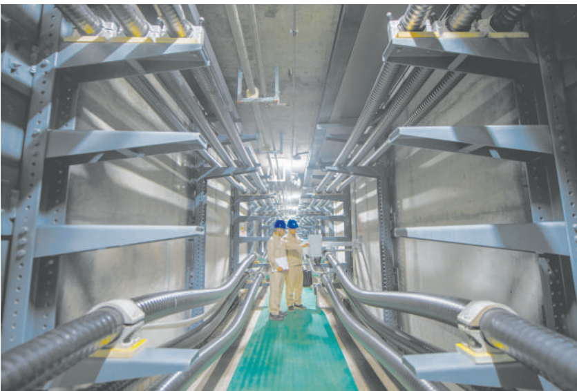
南京110千伏河圩二号线和城圩二号线成功送电
