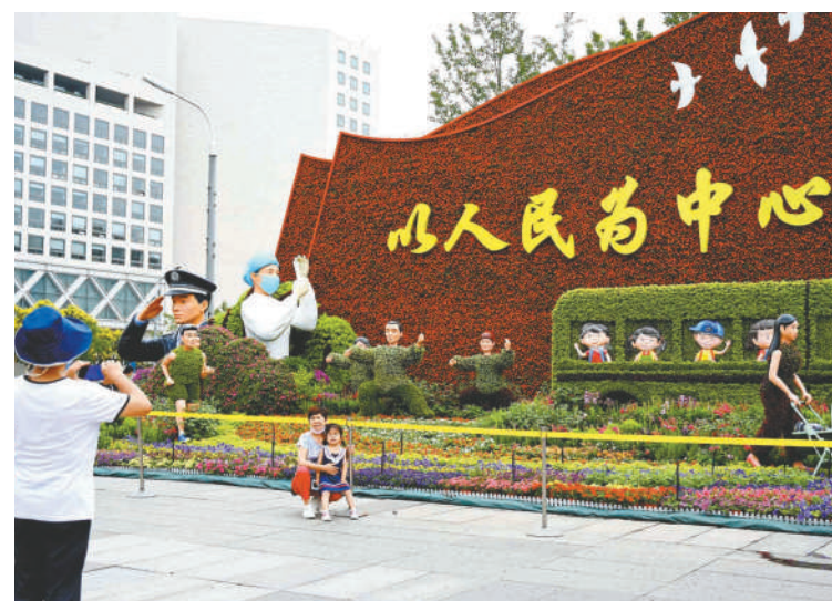
6月16日，在北京西单路口，以反映中国共产党成立100年以来重大历史事件和重要成就为主题的花坛正在施工中，为即将到来的建党100周年献礼。图为建设中的主题花坛吸引行人驻足留影。
