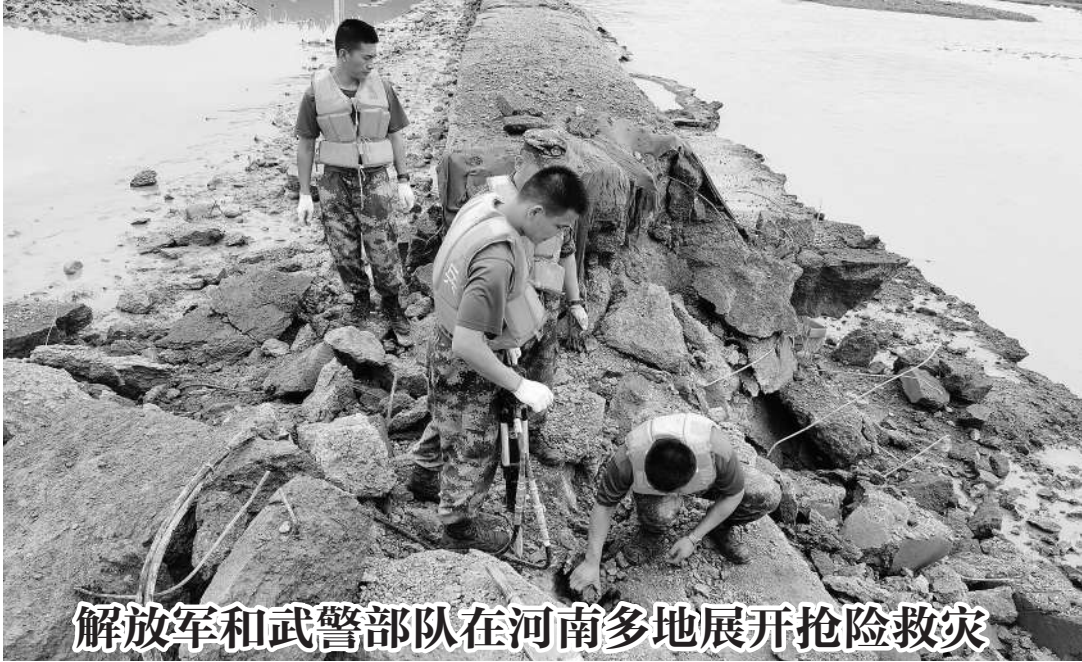
7月21日上午,在河南洛阳伊川县平等乡马回营村伊河拦水坝,中部战区第83集团军某工程防化旅官兵清理爆破后的水泥碎块(手机拍摄)。17日8时至21日14时,强降雨造成河南89个县(市、区)560个乡镇1240737人受灾,因极值暴雨致25人死亡、7人失联。全省已紧急避险转移16325人,紧急转移安置164710人。目前各项抢险救灾工作正在有序开展中。
