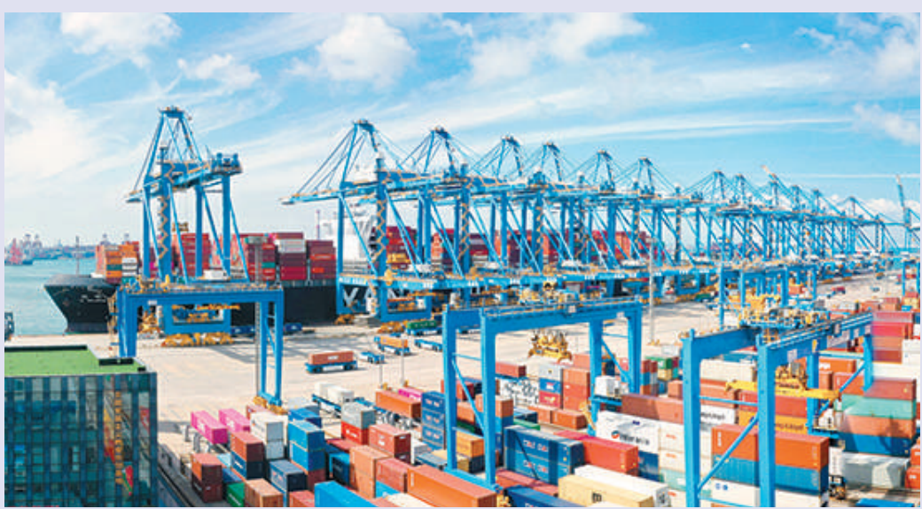
山东港口青岛港全自动化集装箱码头
