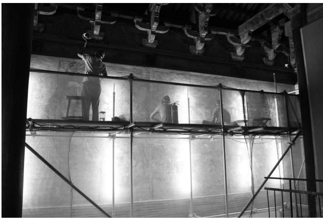
永乐宫重开殿内，技术人员正在对壁画进行修复。
