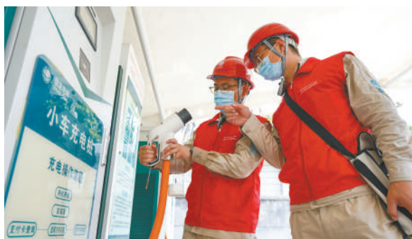
丽水遂昌供电公司员工对景区内充电桩进行日常巡视维护。
