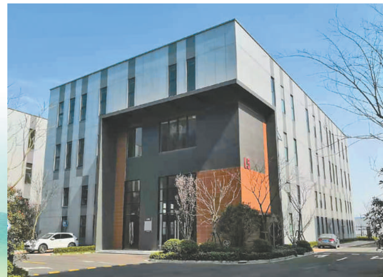
墨靓科技集团公司厂房
