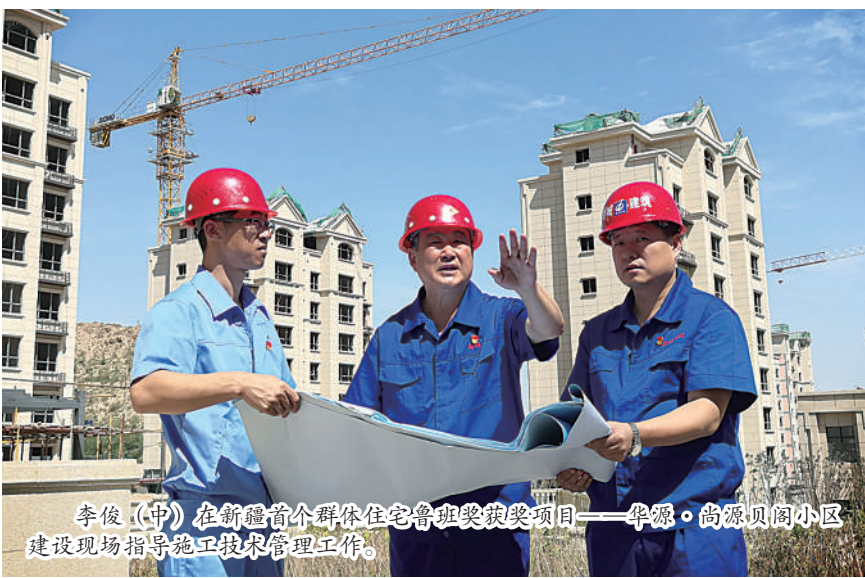
李俊（中）在新疆首个群体住宅鲁班奖获奖项目——华源·尚源悦阁小区建设现场指导施工管理工作。
