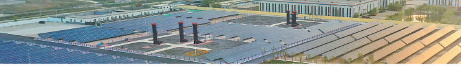
胜利油田功勋——营二井区域实施的风光热储多能互补综合利用项目,每年可发电近900万千瓦时,年减排二氧化碳9000余吨,被誉为“传统能源和新能源结合的典范”。
