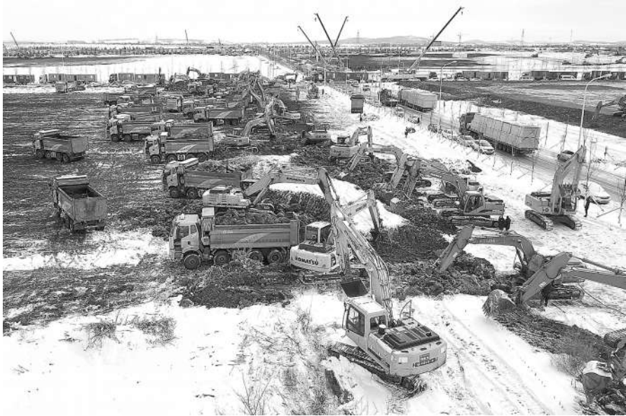
3月16日拍摄的吉林长春兴隆山保税区方舱隔离点一期施工现场（无人机照片）。新华社发
