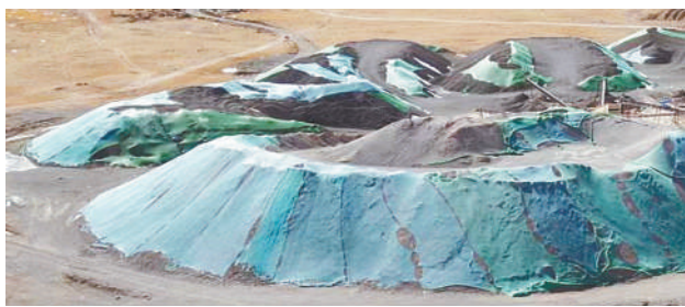
西藏:2022年4月1日,督察组现场督察发现,鑫湖商贸有限公司砂石料场未落实草皮剥离层养护要求,大量砂石堆放在草地上。
