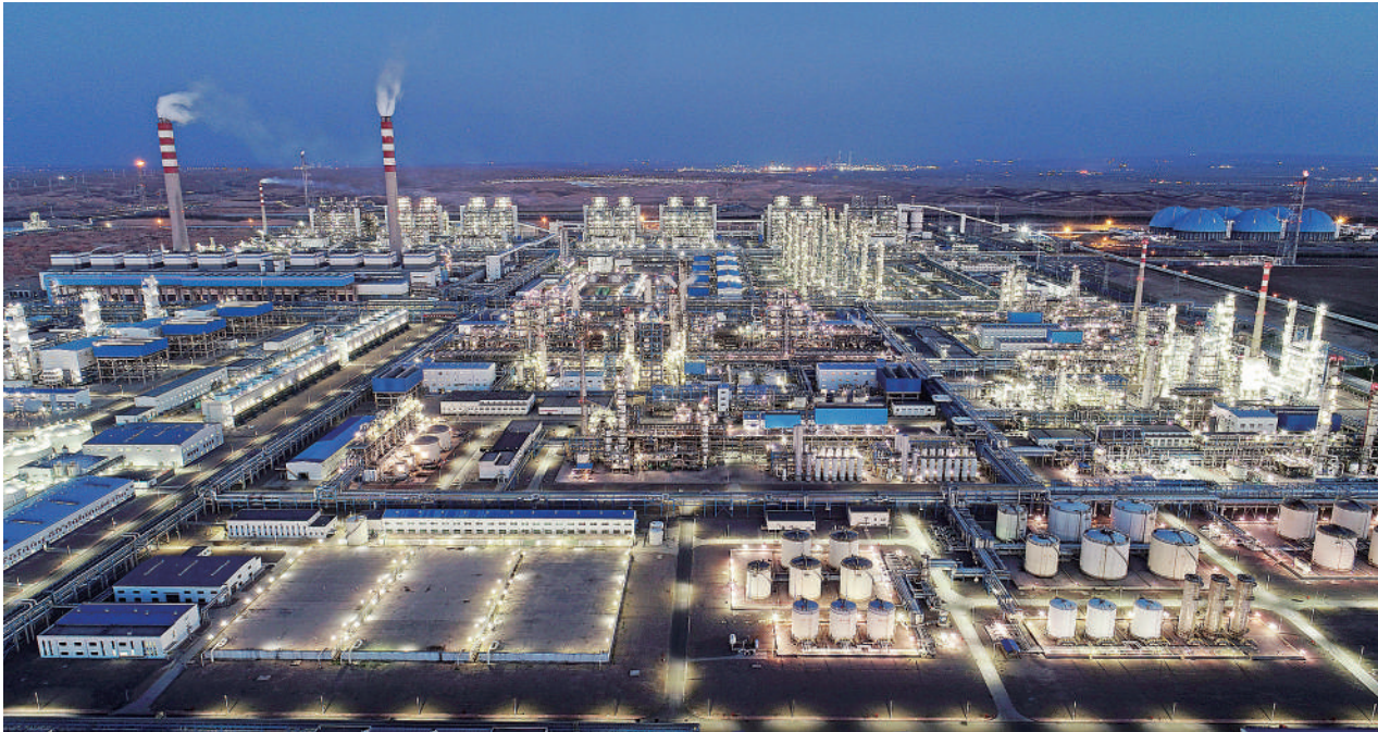
全球单体规模最大的煤制油项目——国家能源集团宁夏煤业公司400万吨煤制油项目,坐落于宁东能源化工基地。近年来,通过优化原料煤的供配方式、锅炉控制优化改造、回收利用燃料气等十几项节能降耗措施,该项目每年节约原煤40万吨,减少二氧化碳排放近90万吨。瞄准减碳增效、绿色发展的目标,宁东能源化工基地正在积极由现代煤化工示范区加快向现代能源经济示范区转型。图为国家能源集团宁夏煤业公司400万吨煤制油项目夜景。 新华社发
