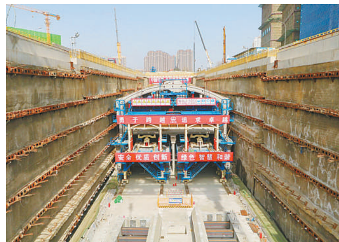
装配式车站—6号线可洛石站拼装现场
