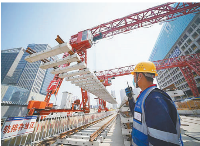
地铁4号线正在进行铺轨施工
