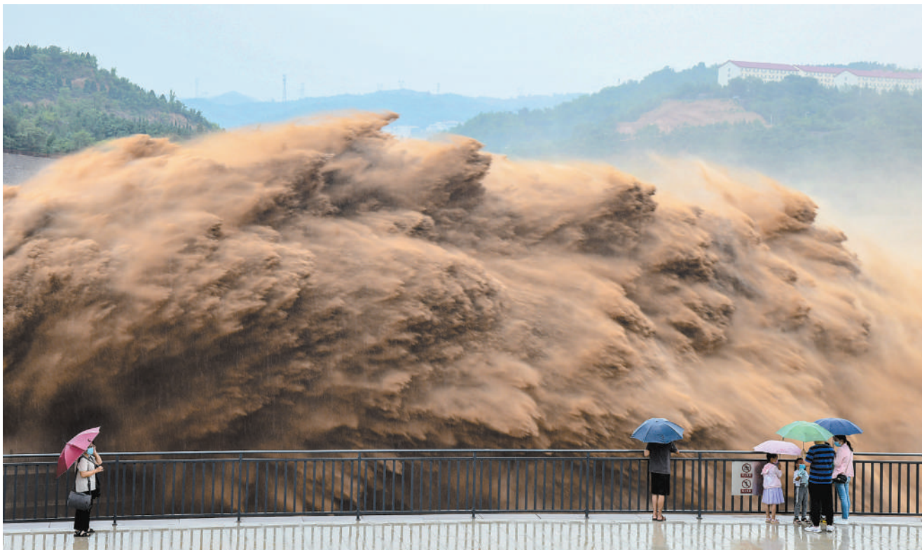
为保障黄河下游防洪安全,黄河小浪底水库于7月17日开始防洪运作,提前降低库水位,留足防洪库容。图为游客观看水库大流量泄洪。
