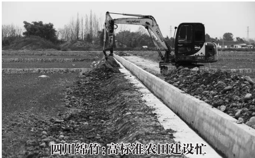
1月14日,在绵竹市新市镇石虎村,挖掘机在整治排灌渠。冬闲时节,四川省绵竹市抓紧建设2022年高标准农田建设项目。 新华社发
