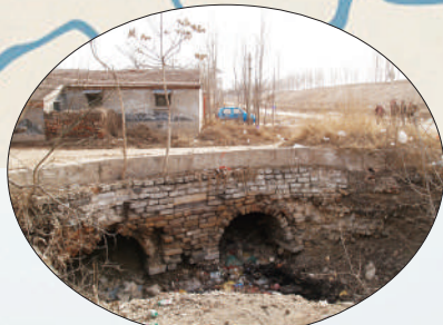
元运河临清闸维修前
