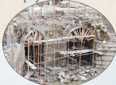
元运河临清闸维修中
