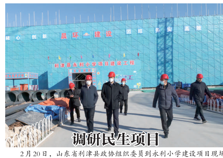
2月20日，山东省利津县政协组织委员到永利小学建设项目现场进行实地调研并深入座谈交流，详细了解项目工程进度，积极协调解决项目推进中的困难。 李俊三 顾龙 摄
