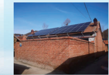
河北公司（雄安公司）承德平泉市分布式光伏+电取暖项目
