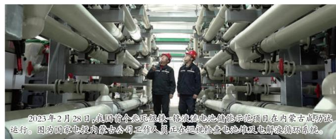
2023年2月28日,我国首个兆瓦级铁-铬液流电池储能示范项目在内蒙古成功试运行。因为国家电投内蒙古公司工作人员正在巡视检查电池堆及电解液循环系统。
