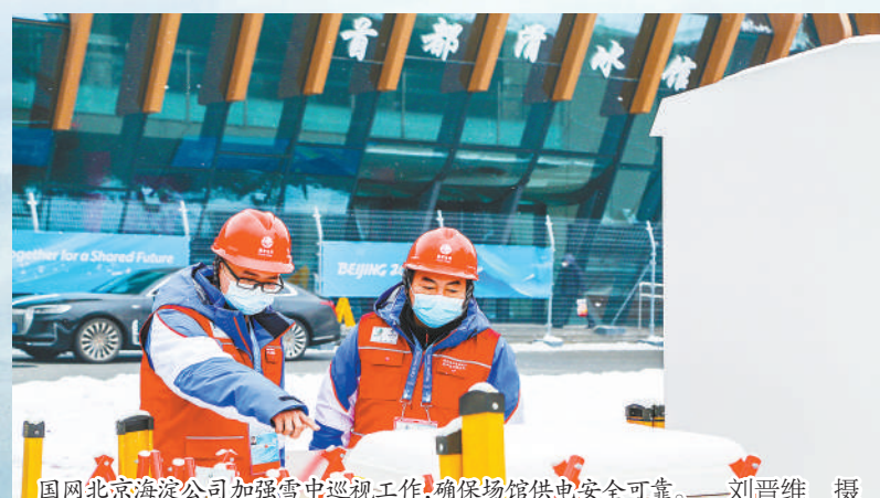
国网北京海淀公司加强雪中巡视工作，确保场馆供电安全可靠。刘晋维 摄
