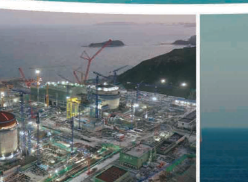
中广核广东太平岭核电项目“华龙一号”建设现场
