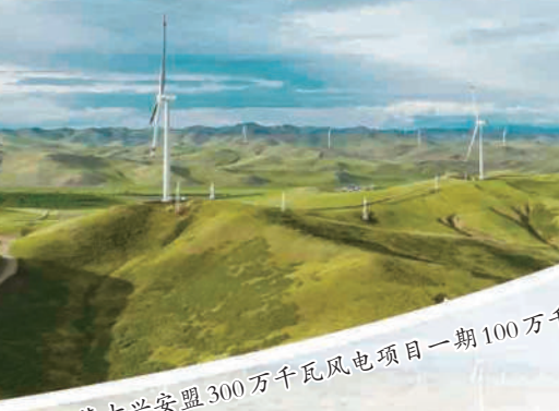
中广核内蒙古兴安盟300万千瓦风电项目一期100万千瓦项目
