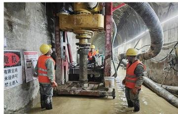
洞内机械成孔灌注桩，简称洞桩，公司承担并完成北京部分地铁洞桩项目。
