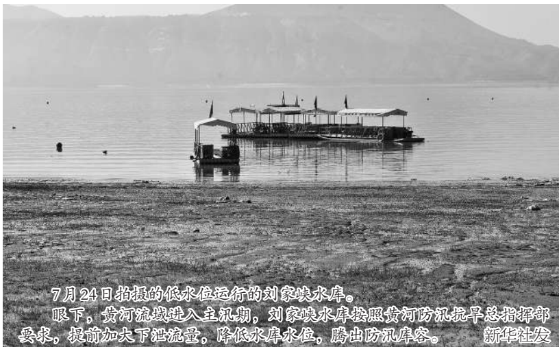
7月24日拍摄的低水位运行的刘家峡水库。眼下,黄河流域进入主汛期,刘家峡水库按照黄河防汛抗旱总指挥部要求,提前加大下泄流量,降低水库水位,腾出防汛库容。新华社发
