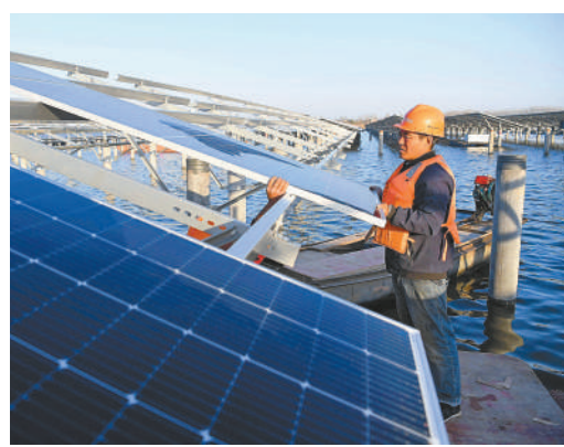
技术人员进行光伏板主动标识数据采集载体安装
