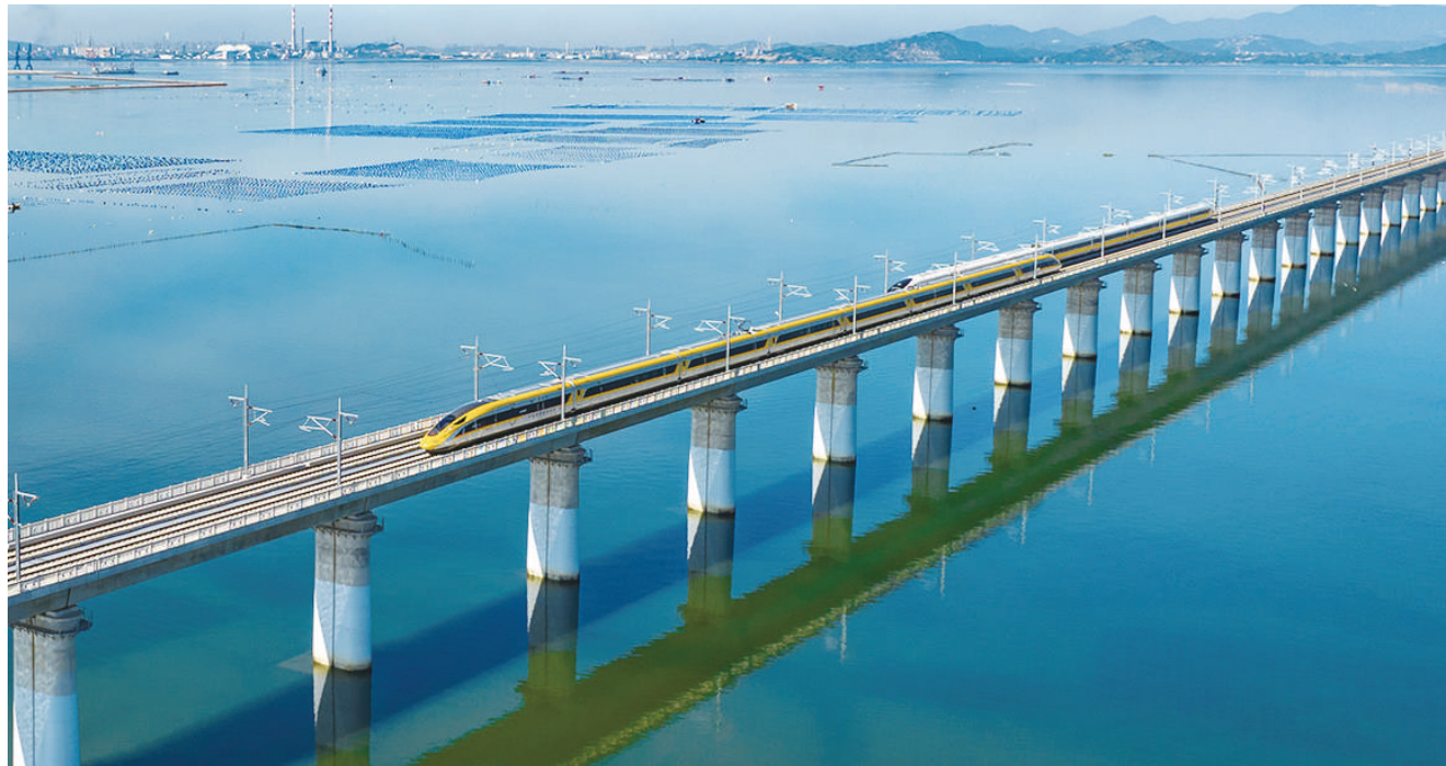
CR450动车组新技术部件性能验证试验在福厦高铁创造单列时速453公里、相对交会时速891公里运行新纪录。
