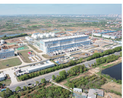
湖北应城300兆瓦压缩空气储能电站示范工程
