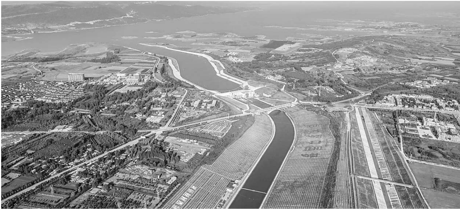
南水北调中线工程“水龙头”——陶岔渠首枢纽。
